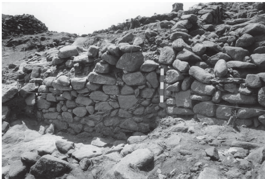
Fig. 14: Enlace de los muros B1 y B2 desde el E (IAA Madrid, Inst. Neg, Nr. KB 23-04-6).
